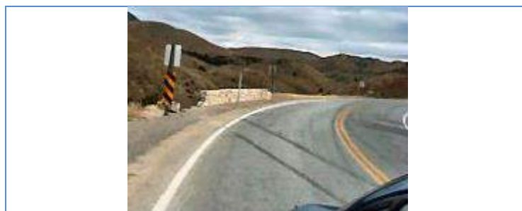
Một chiếc xe trượt sau khi rẽ khúc cua. tạo ra vết tiếp tuyến với vạch kẻ đường đôi màu vàng
