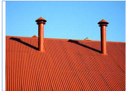
Mái nhà bằng tấm sắt lượn sóng
